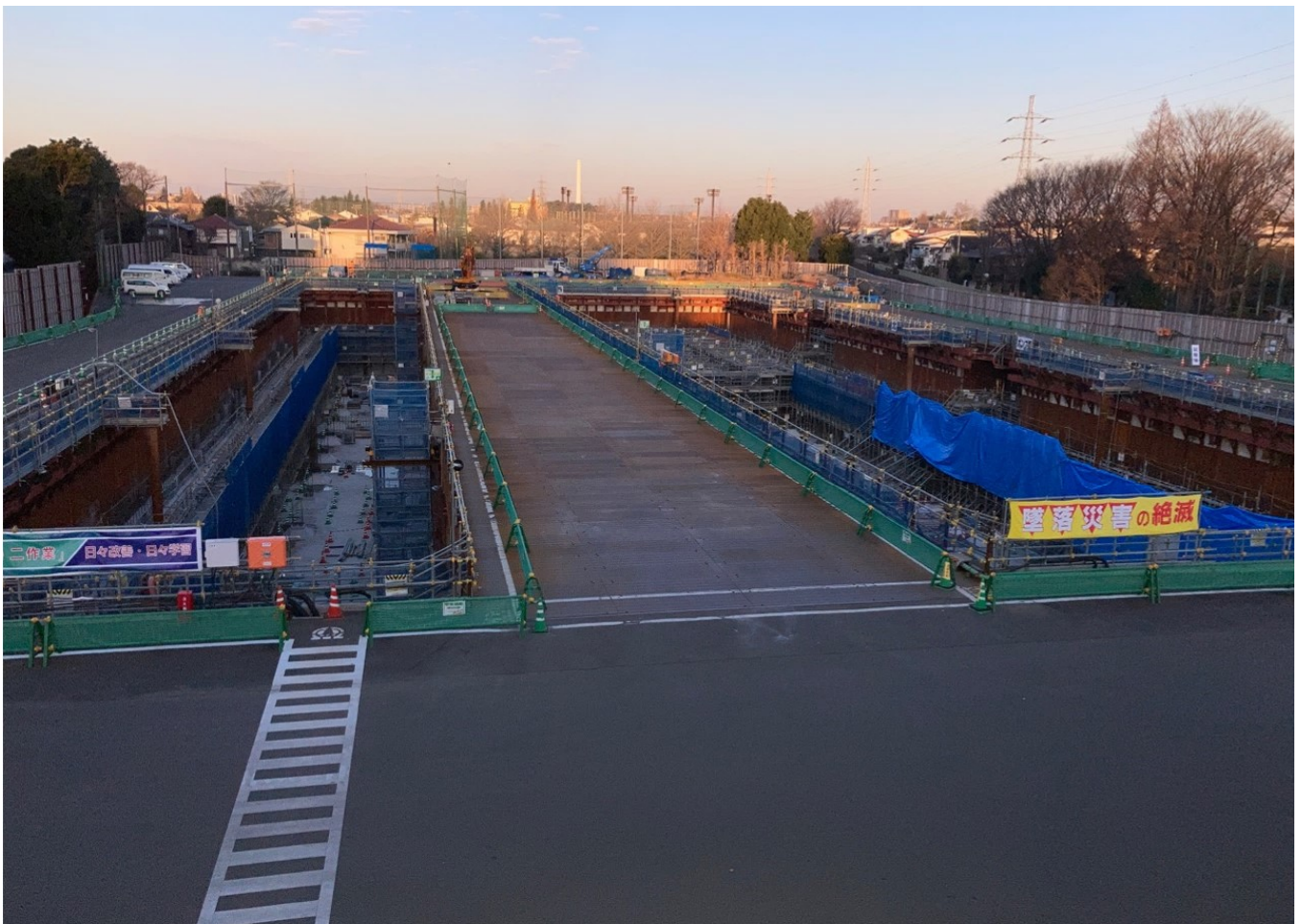
調節池ヤード 南側を望む
