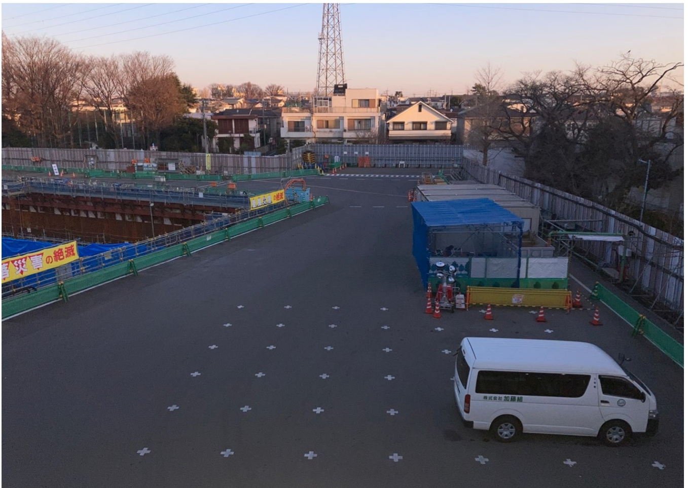
調節池ヤード 北側を望む
