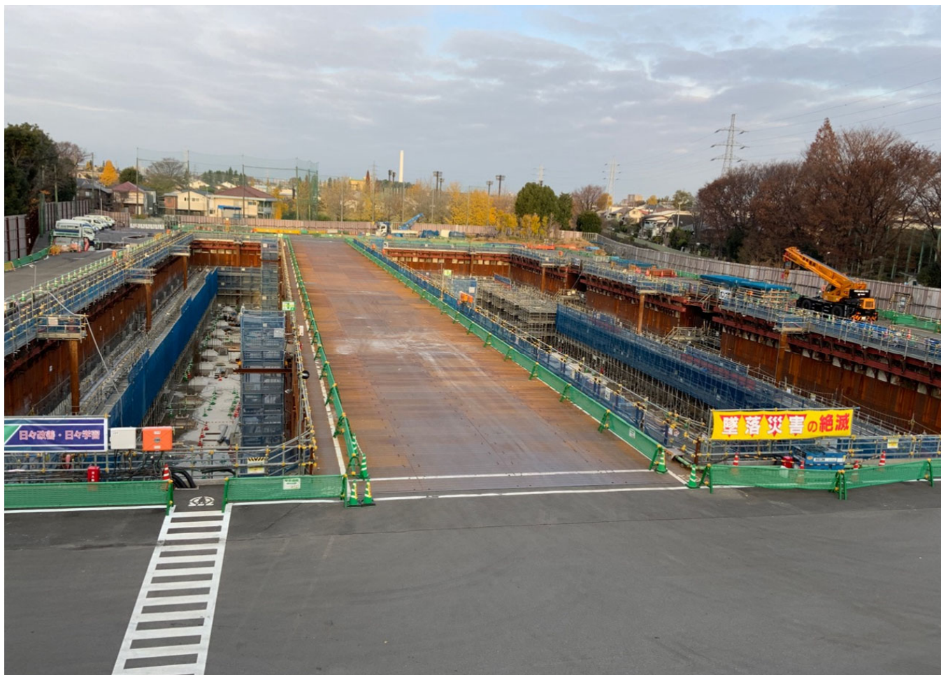
調節池ヤード 南側を望む
