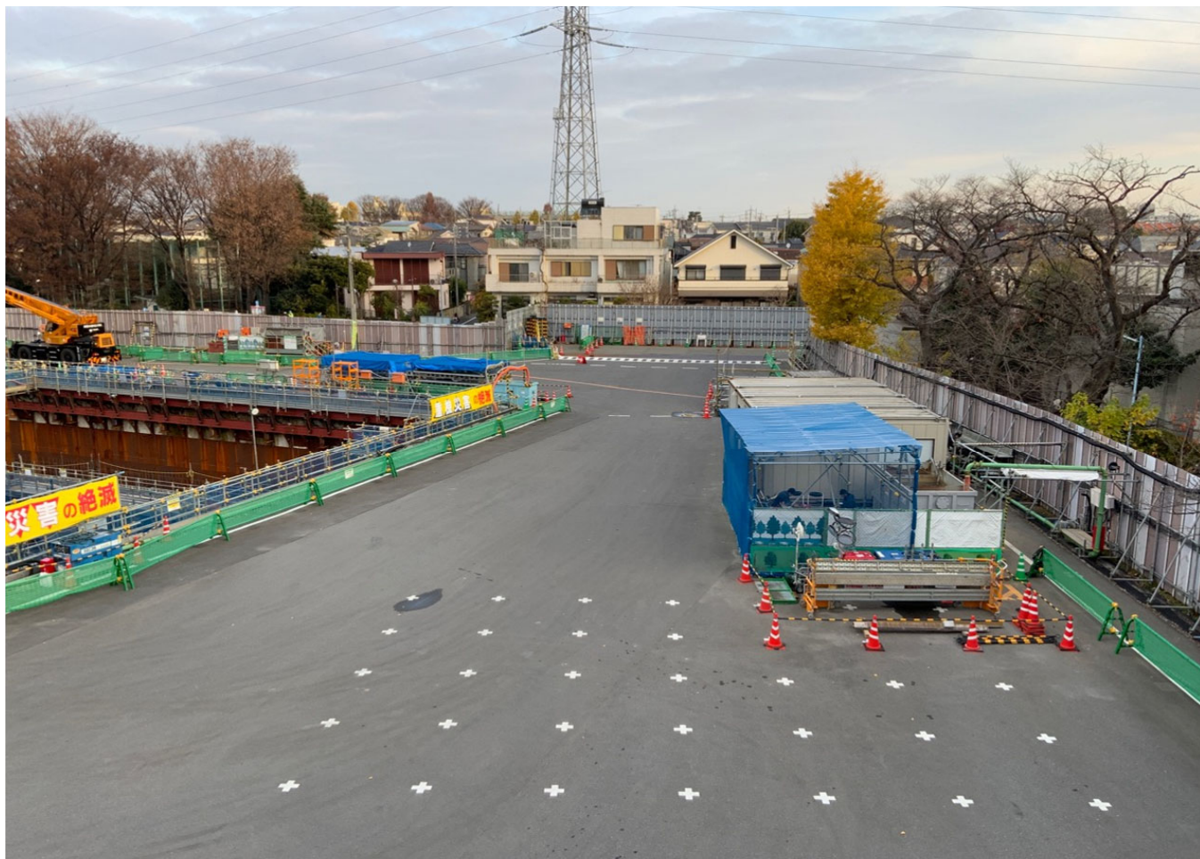
調節池ヤード 北側を望む
