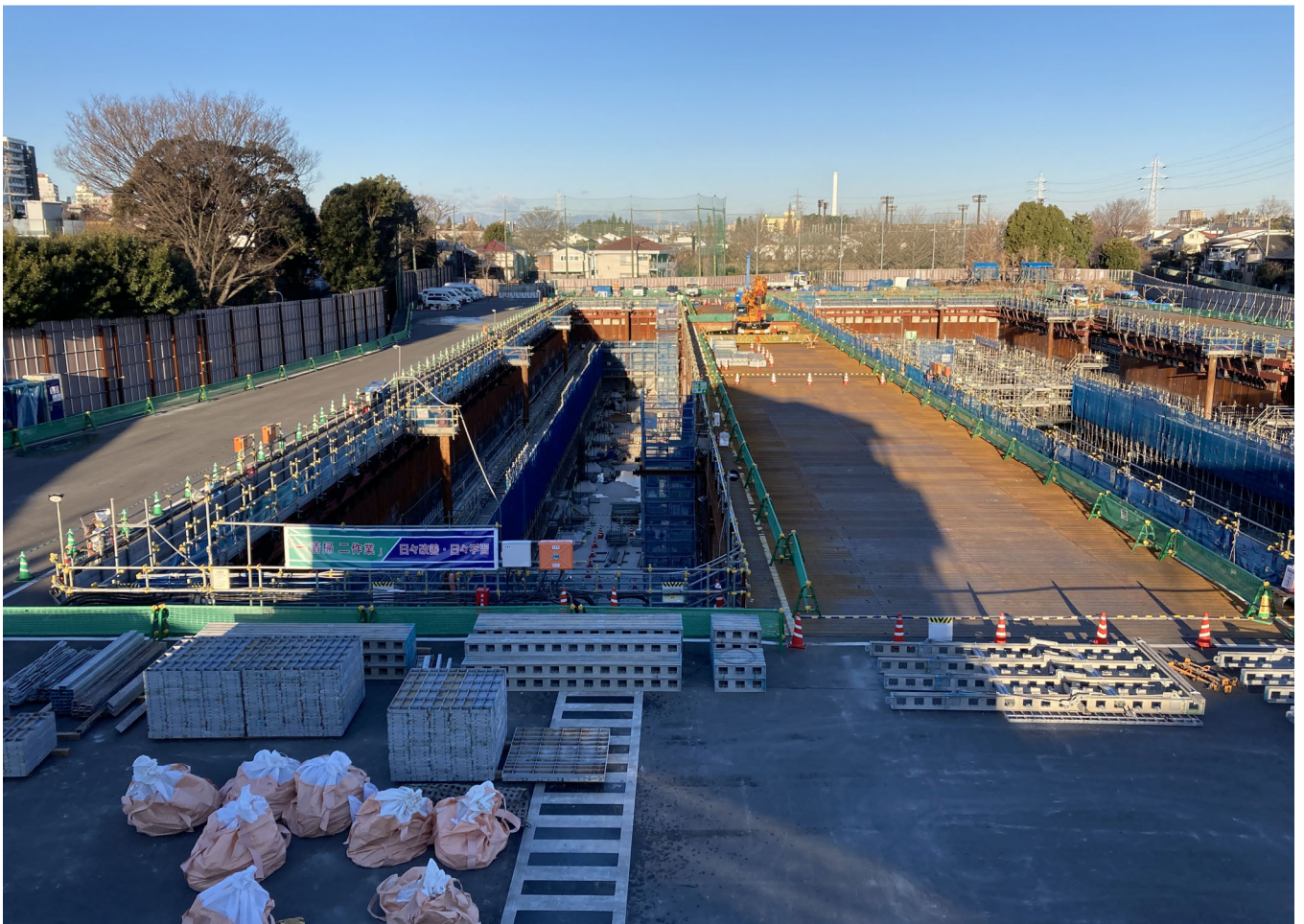
調節池ヤード 南側を望む
