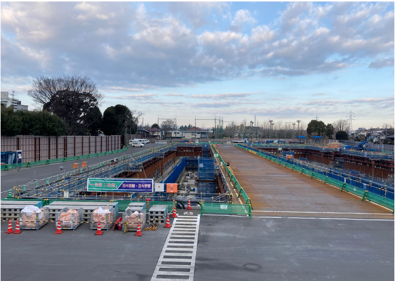
調節池ヤード 南側を望む
