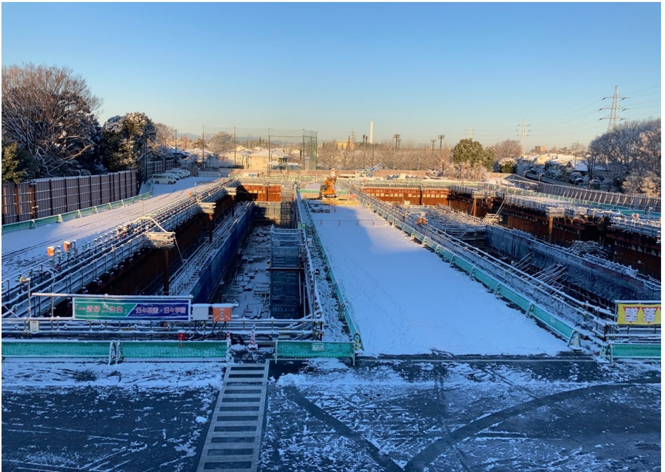
調節池ヤード 南側を望む
