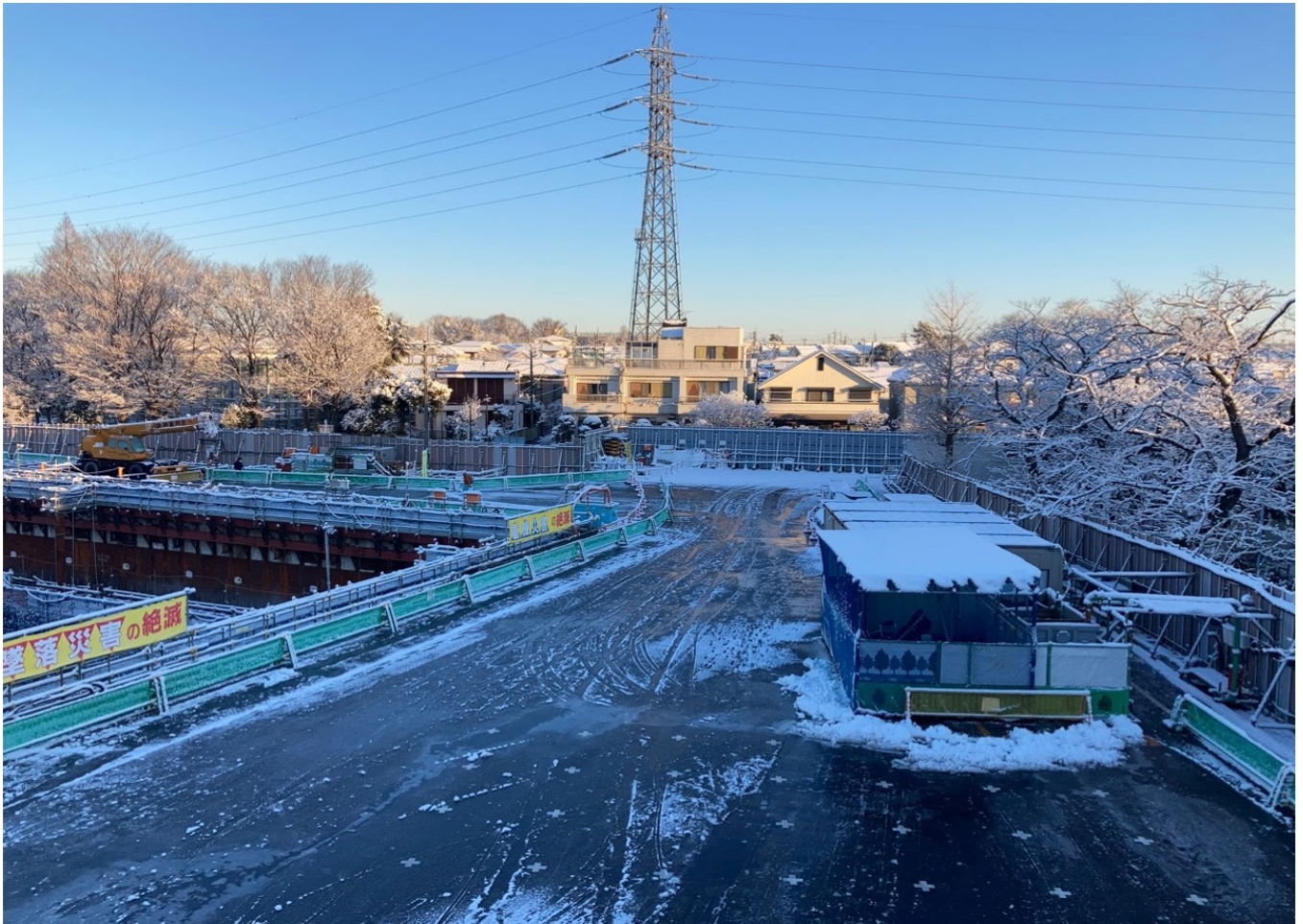
調節池ヤード 北側を望む
