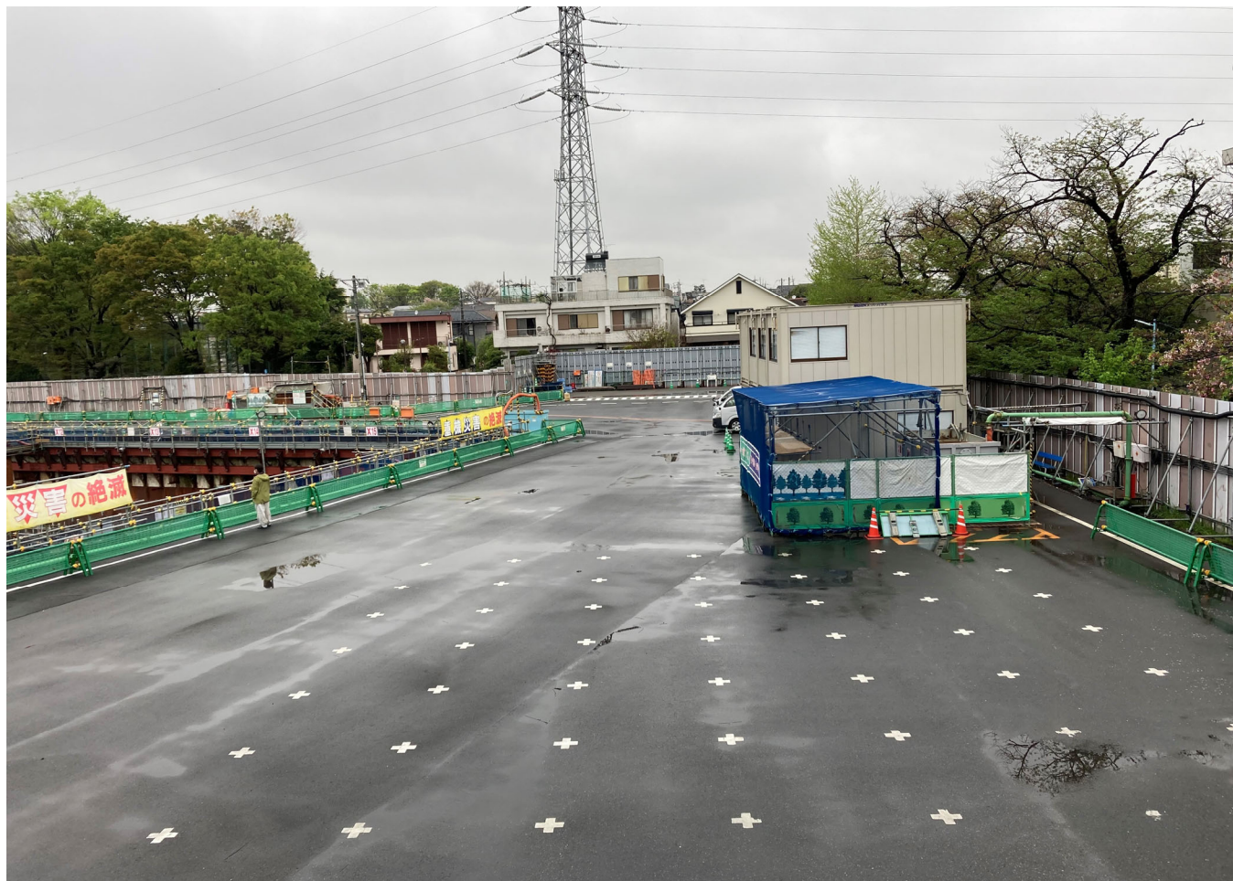
調節池ヤード 北側を望む
