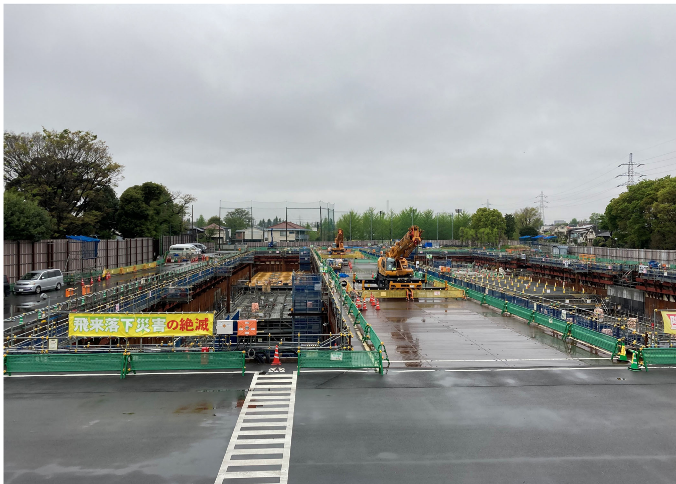
調節池ヤード 南側を望む
