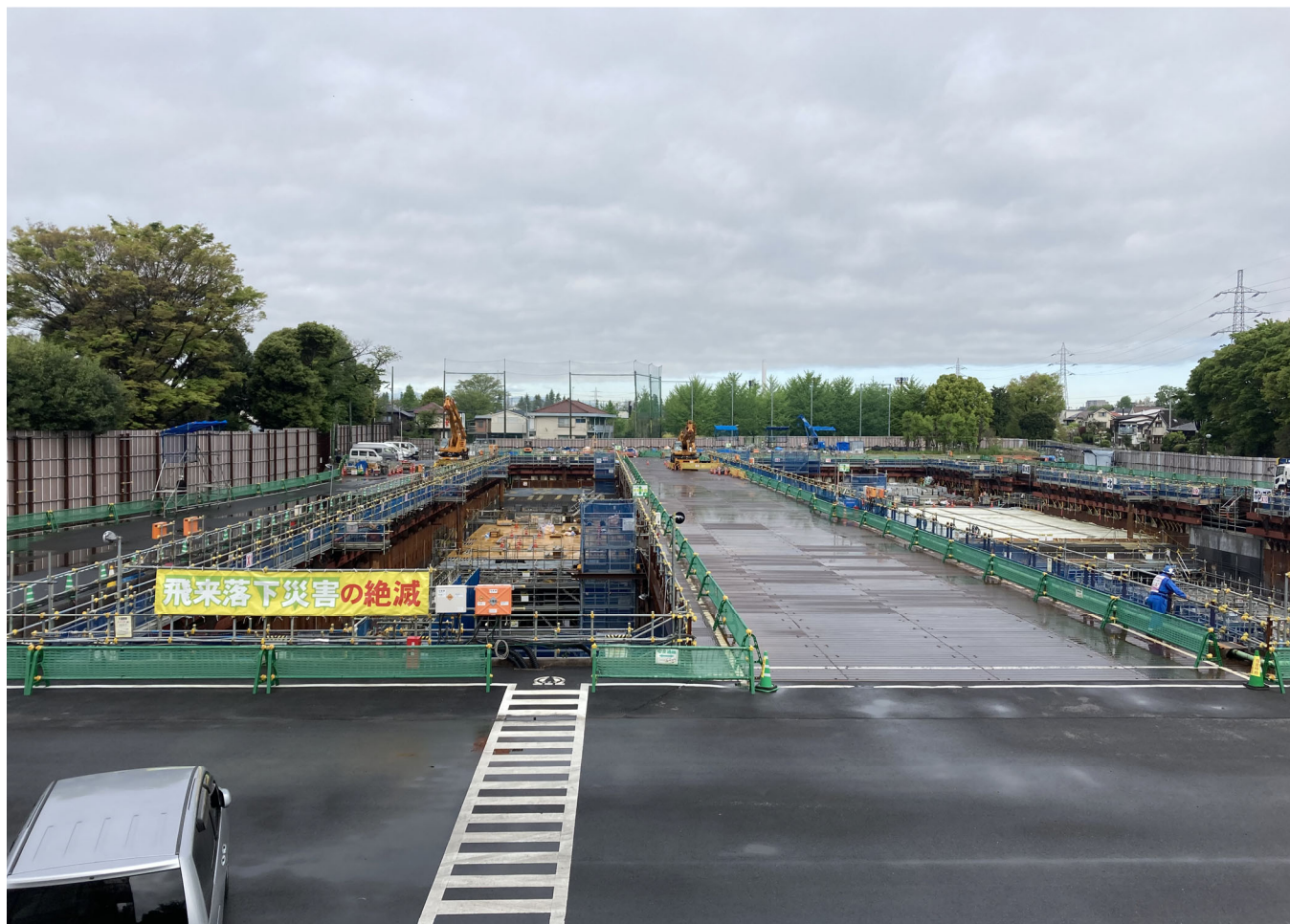
調節池ヤード 南側を望む
