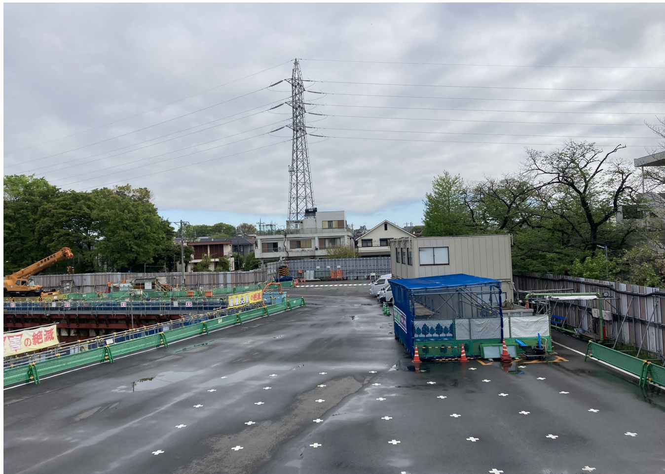
調節池ヤード 北側を望む
