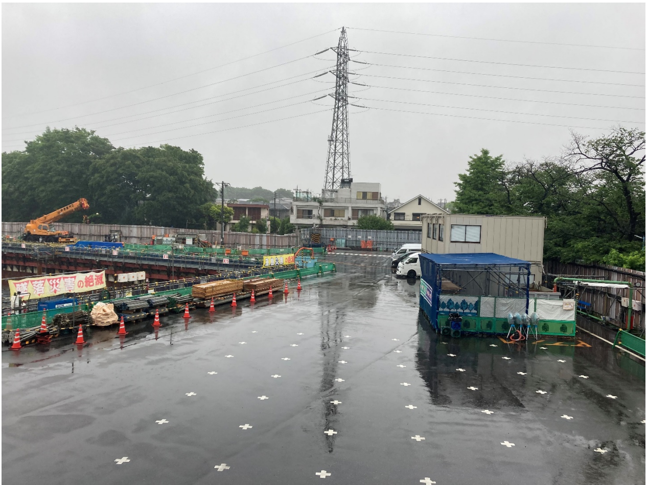
調節池ヤード 北側を望む
