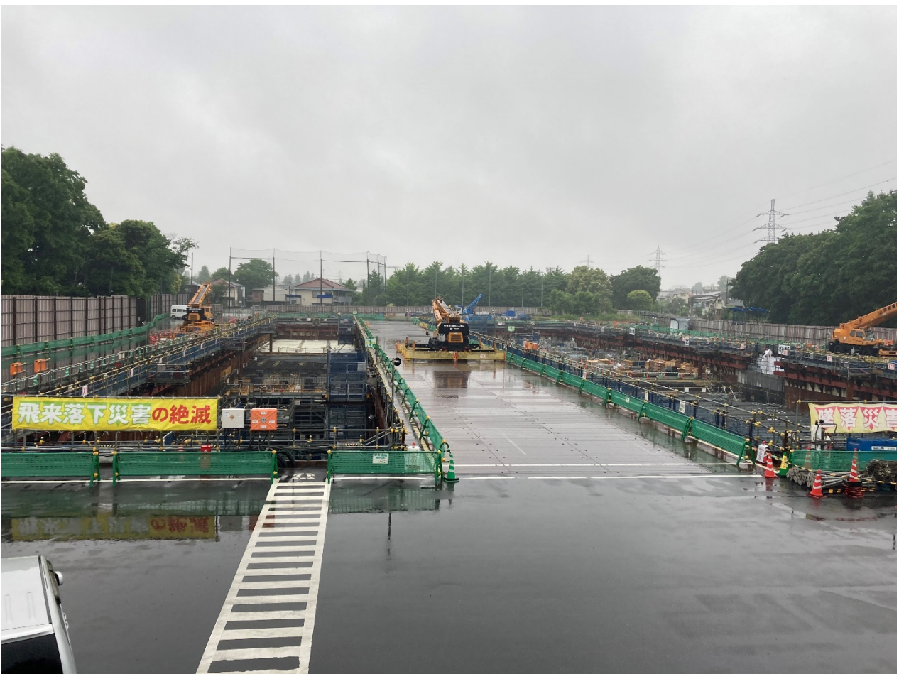
調節池ヤード 南側を望む
