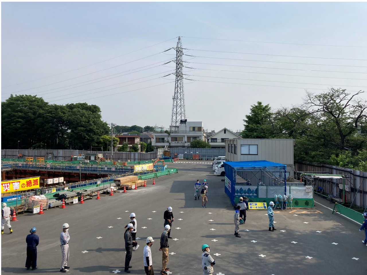
調節池ヤード 北側を望む
