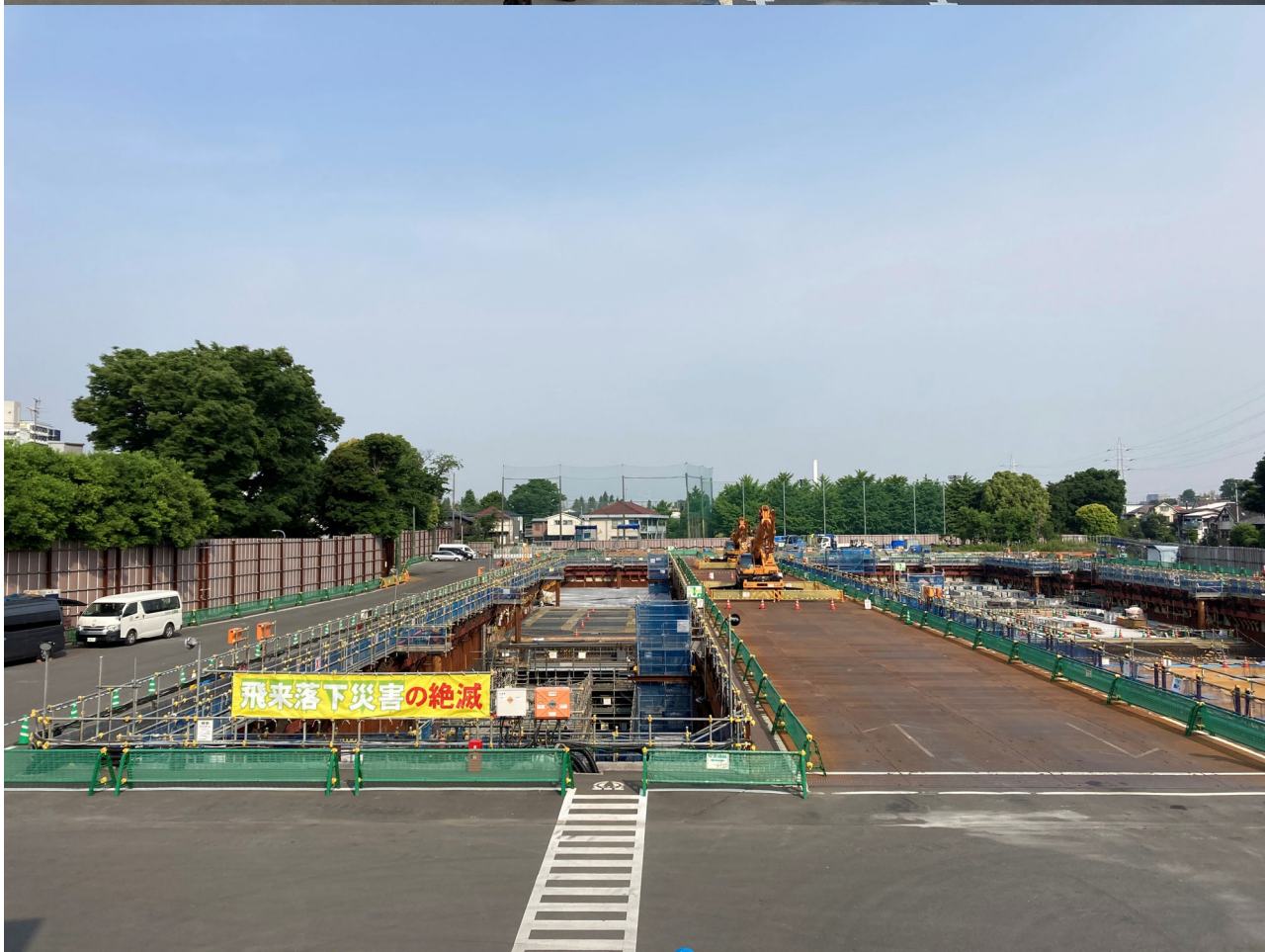
調節池ヤード 南側を望む
