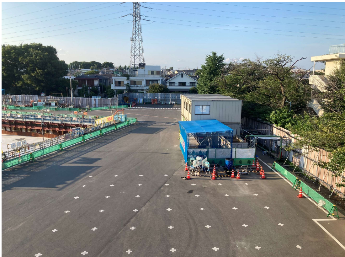
調節池ヤード 南側を望む
