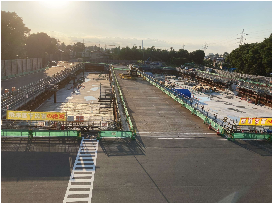
調節池ヤード 北側を望む
