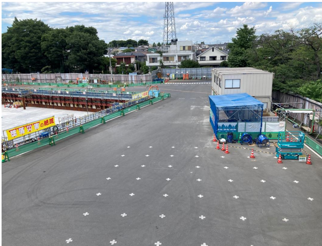
調節池ヤード 北側を望む
