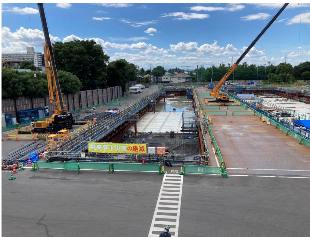
調節池ヤード 南側を望む
