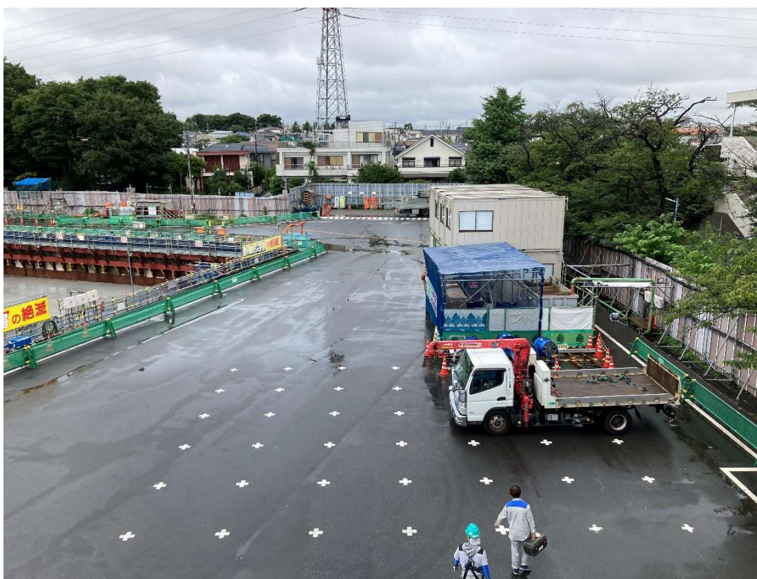
調節池ヤード 南側を望む
