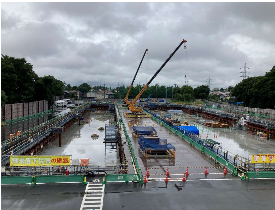
調節池ヤード 北側を望む
