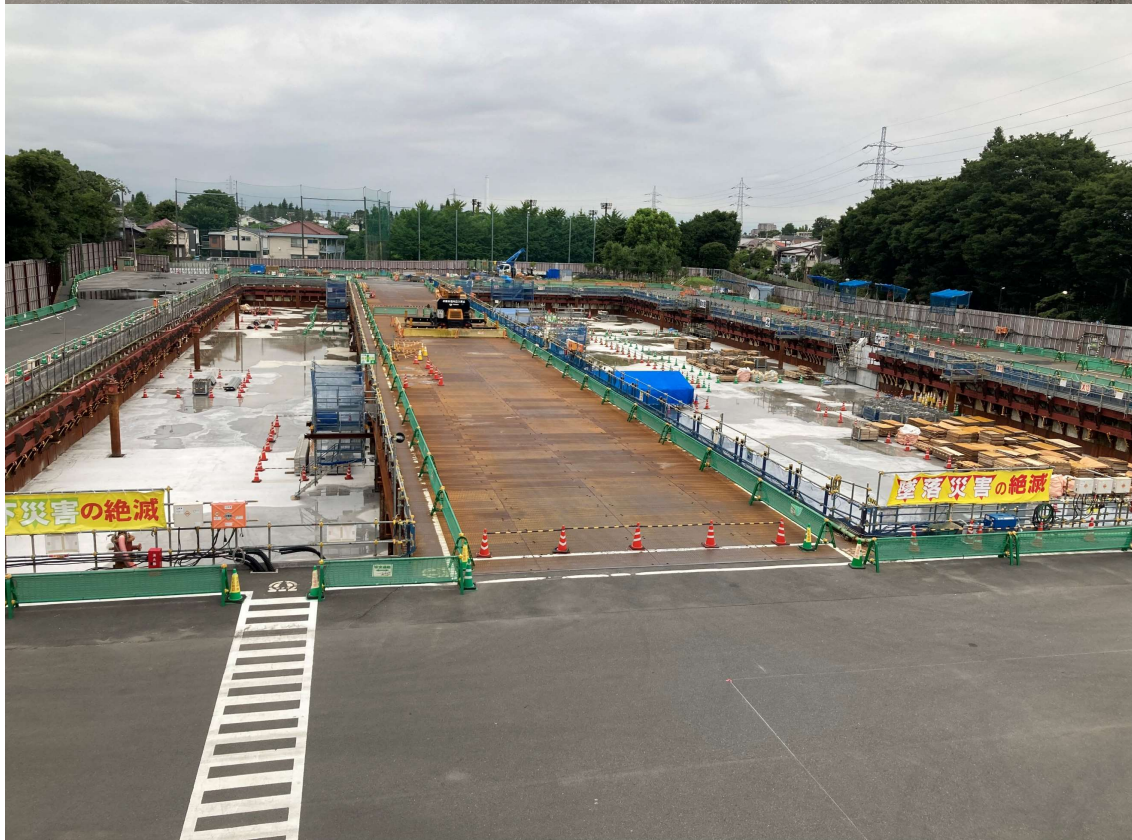
調節池ヤード 南側を望む
