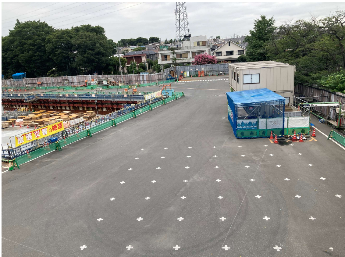
調節池ヤード 北側を望む
