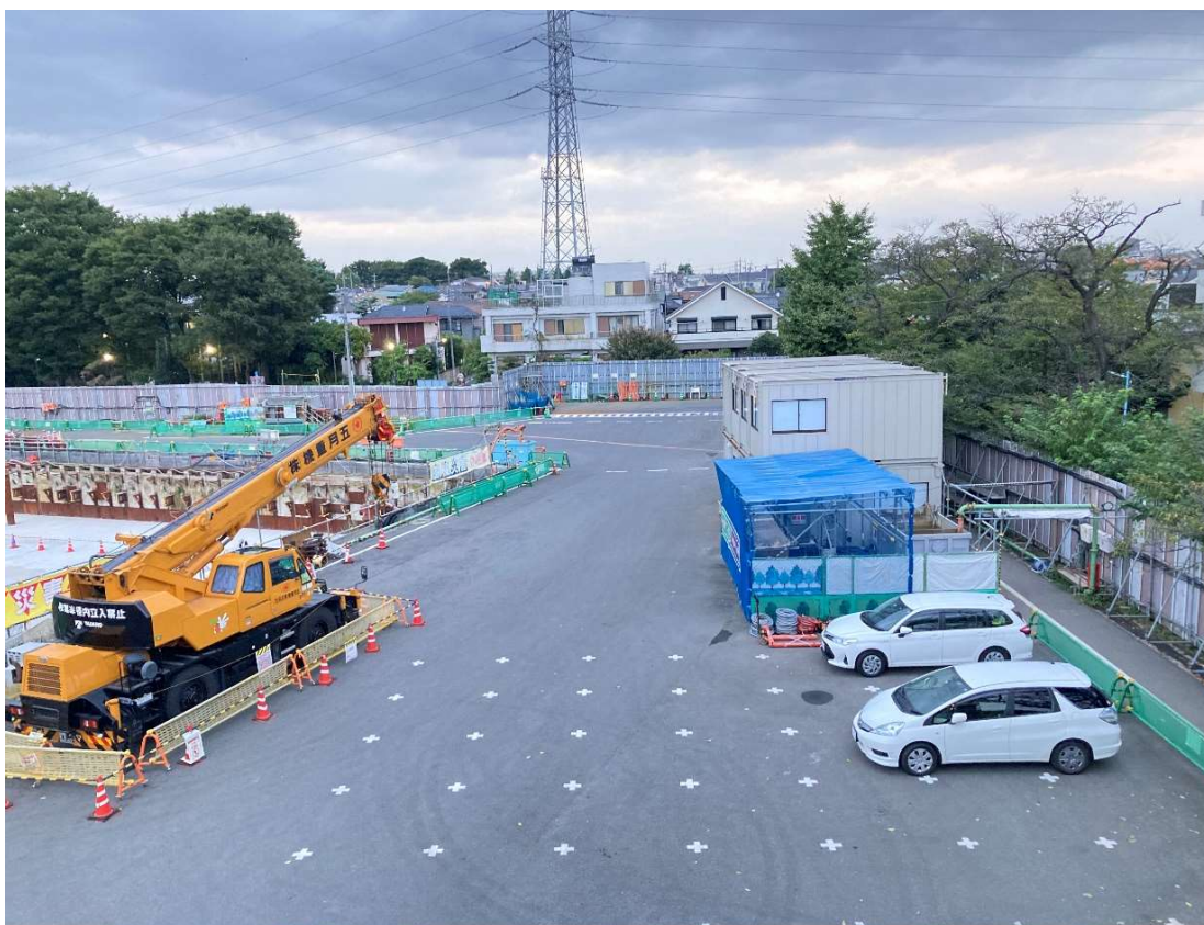
調節池ヤード 北側を望む
