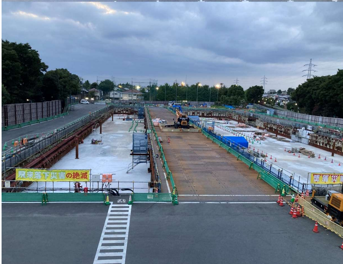
調節池ヤード 南側を望む
