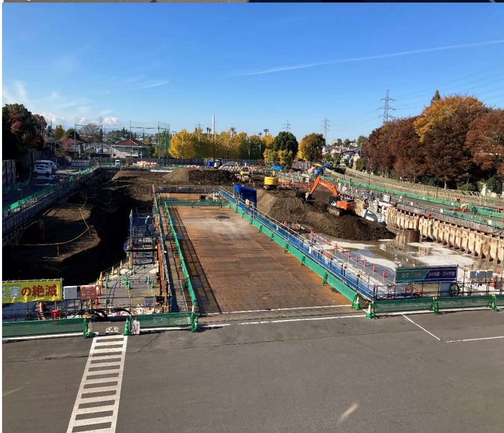
調節池ヤード 南側を望む
