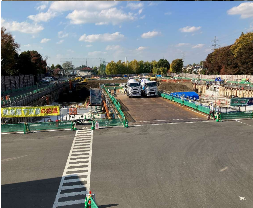
調節池ヤード 南側を望む
