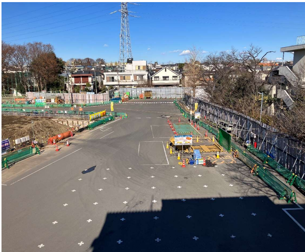
調節池ヤード 北側を望む
