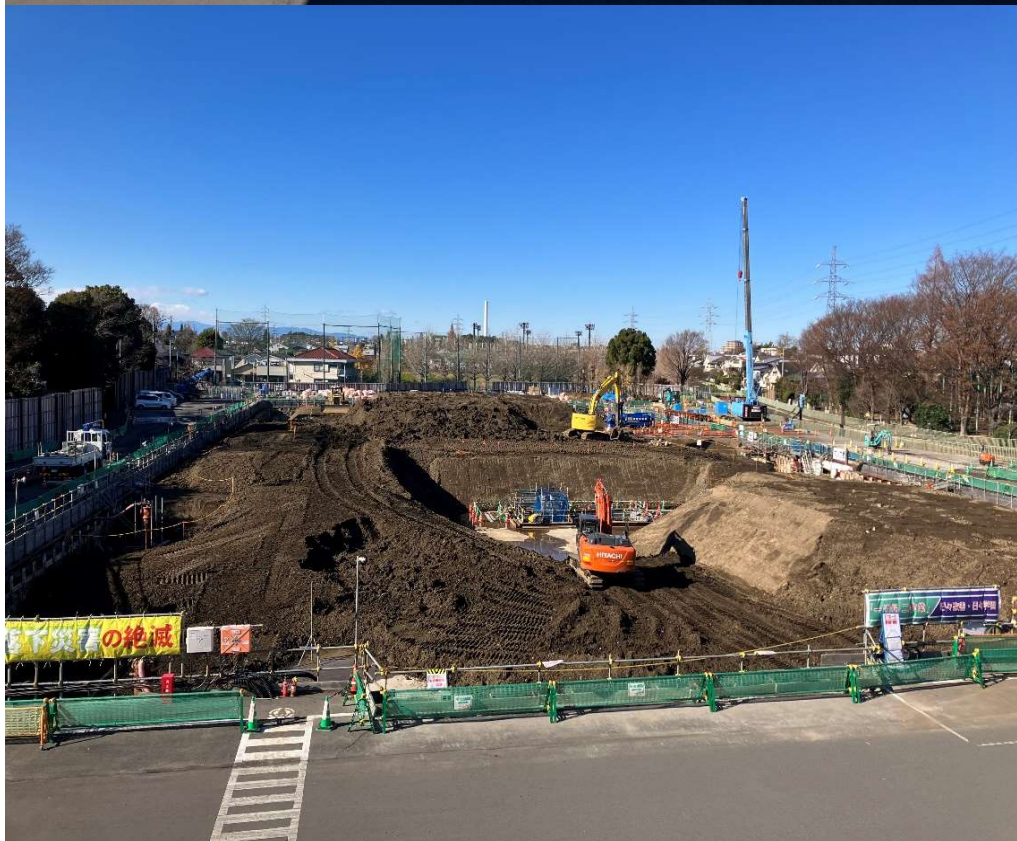
調節池ヤード 南側を望む
