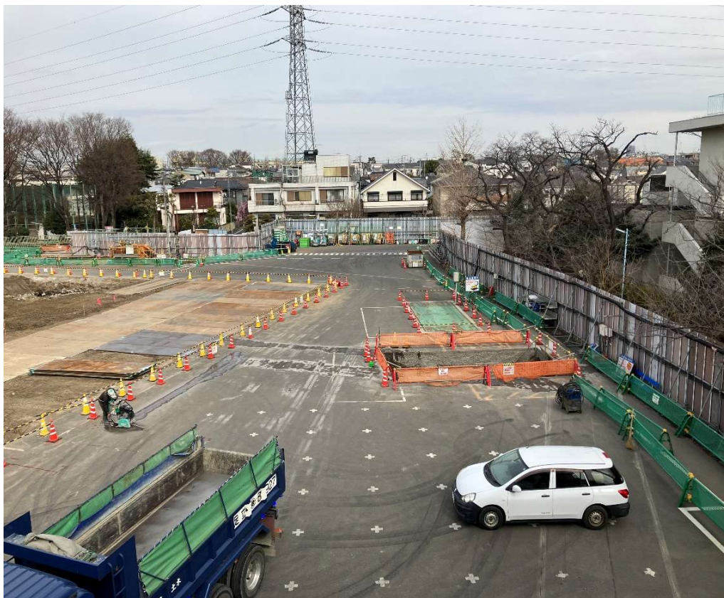
調節池ヤード 北側を望む
