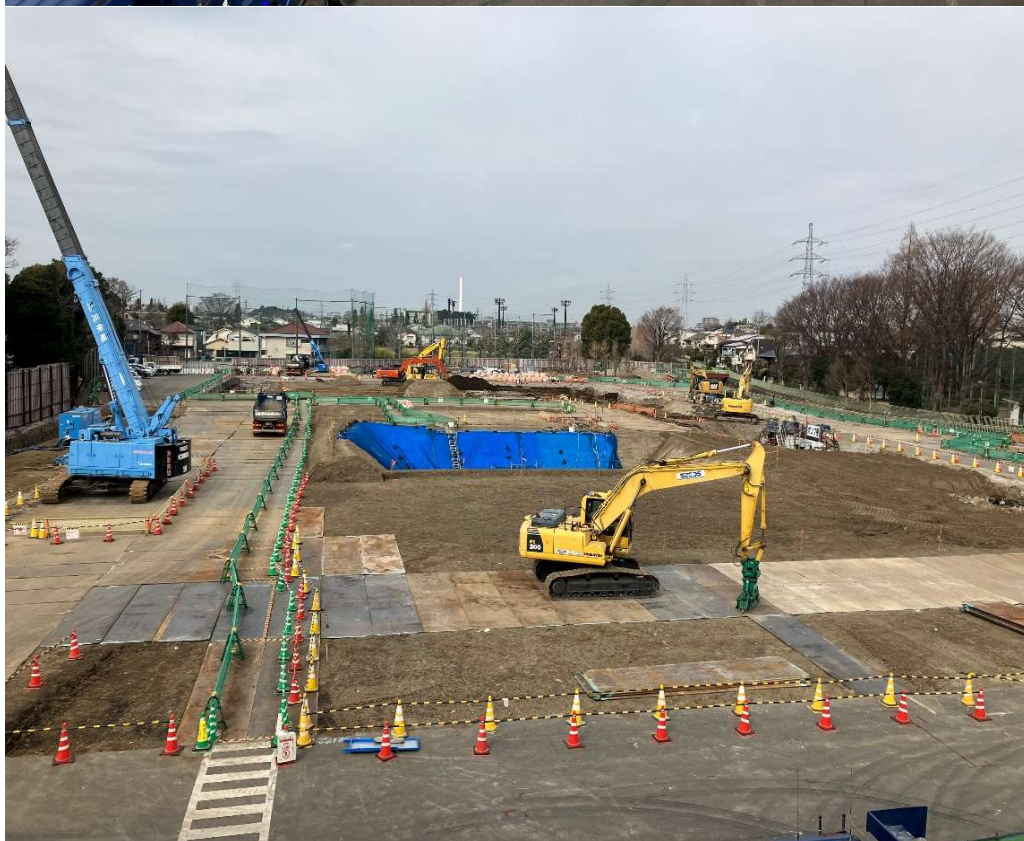
調節池ヤード 南側を望む
