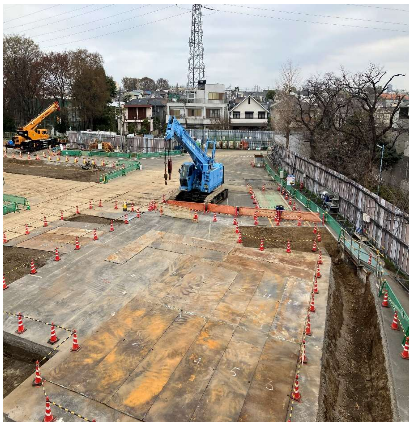
調節池ヤード 北側を望む
