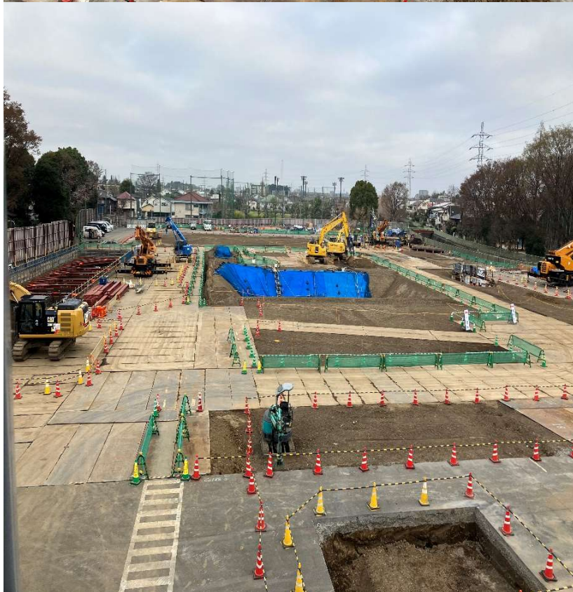
調節池ヤード 南側を望む
