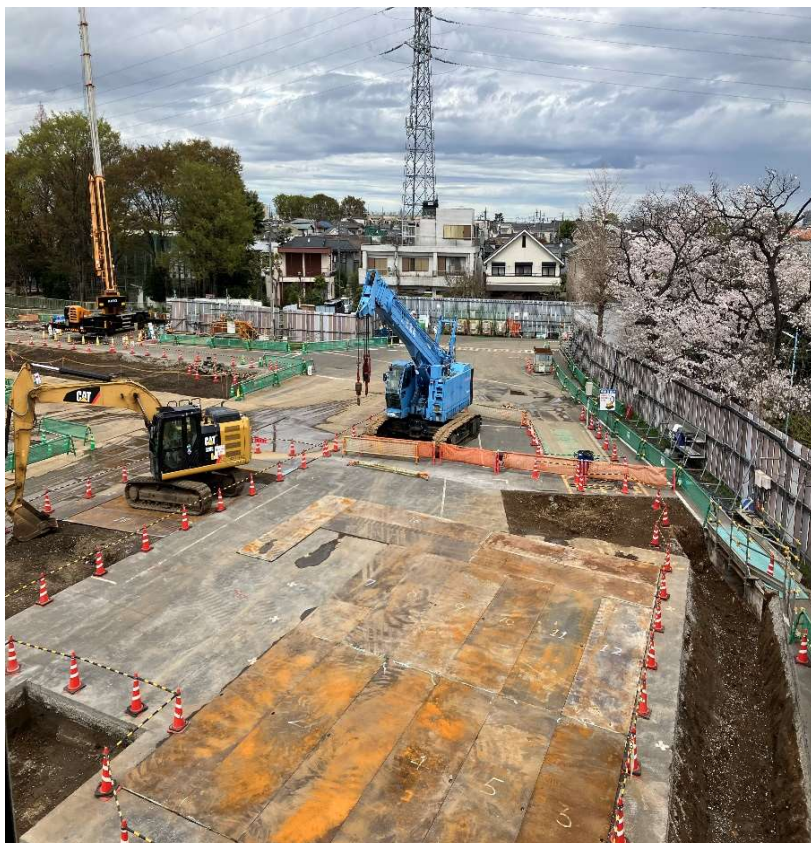
調節池ヤード 北側を望む
