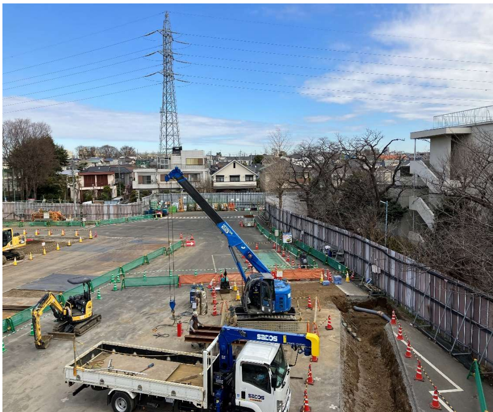
調節池ヤード 北側を望む
