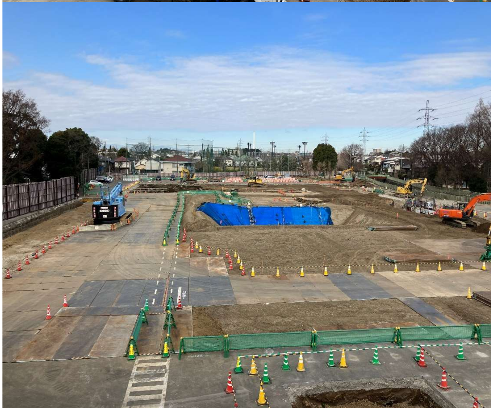
調節池ヤード 南側を望む
