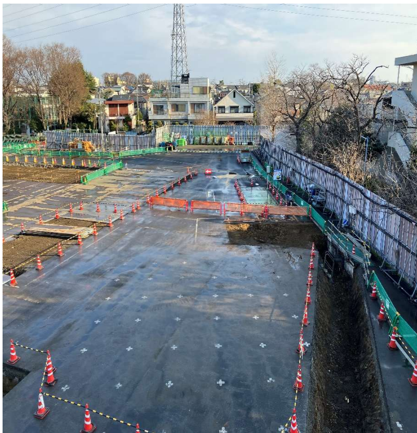
調節池ヤード 北側を望む
