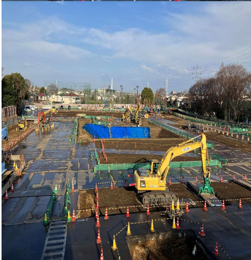
調節池ヤード 南側を望む
