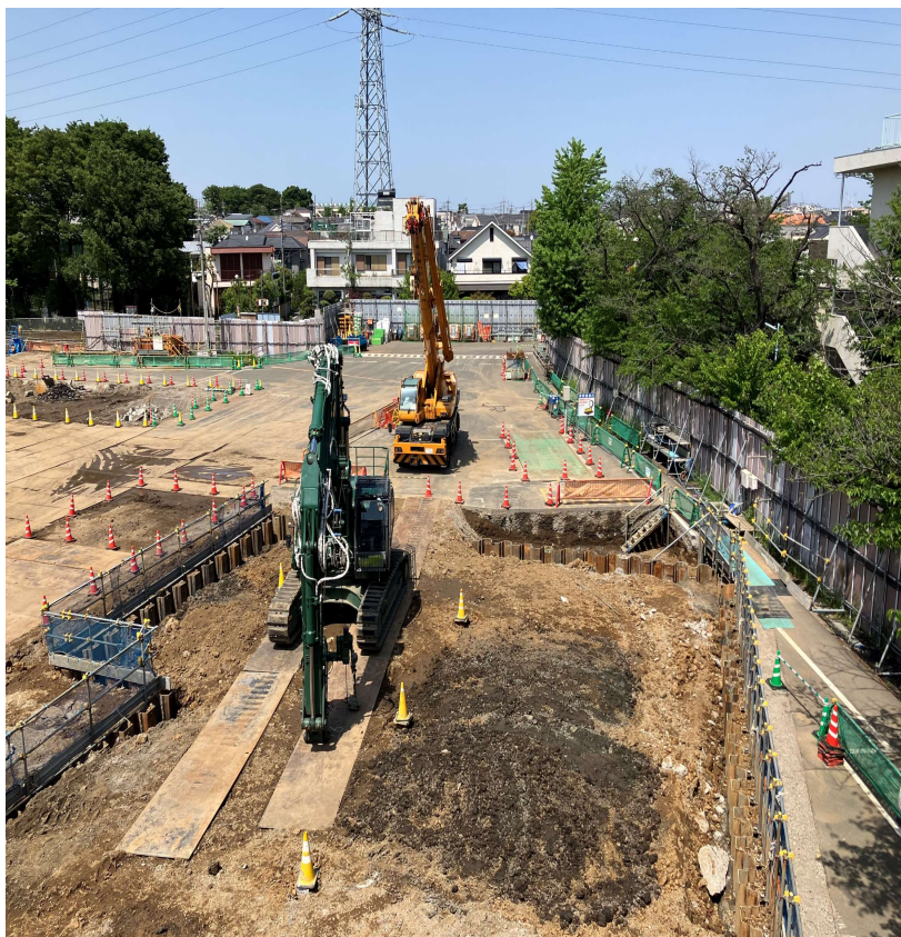
調節池ヤード 北側を望む
