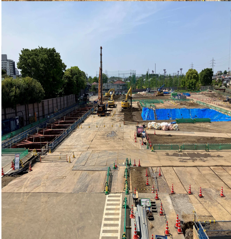
調節池ヤード 南側を望む
