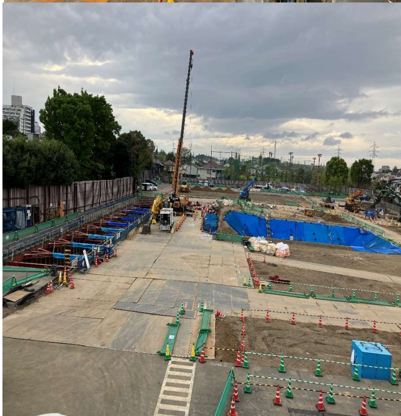
調節池ヤード 南側を望む
