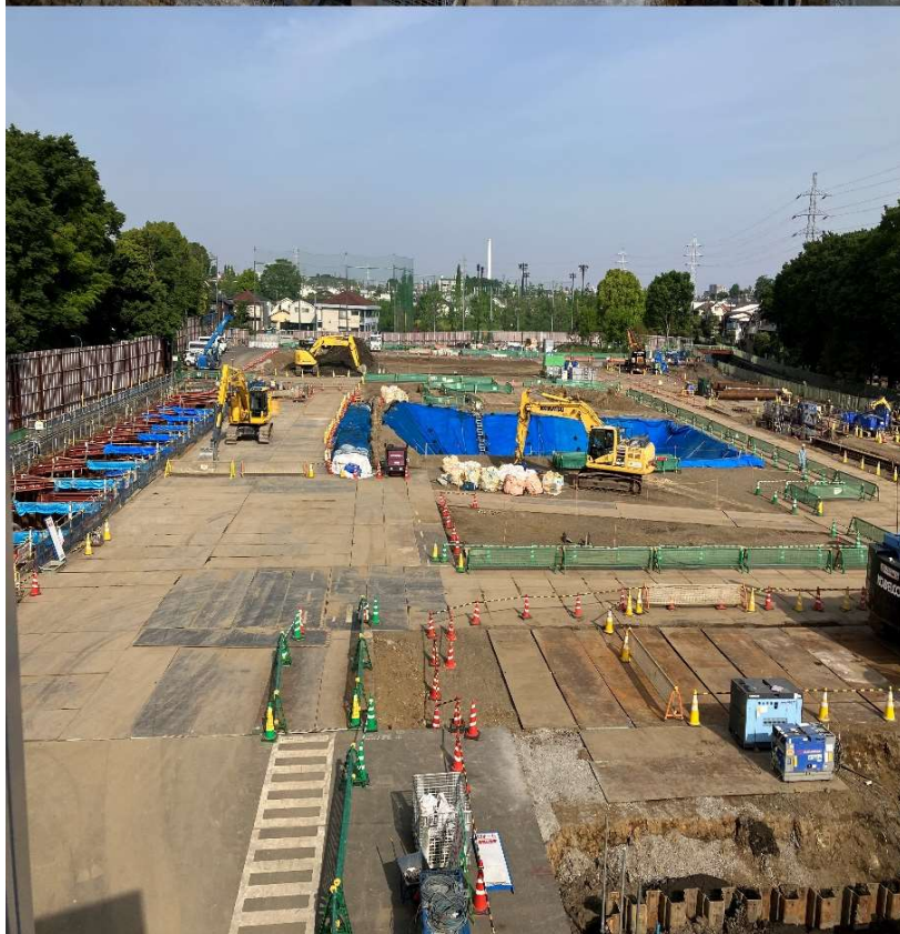
調節池ヤード 南側を望む
