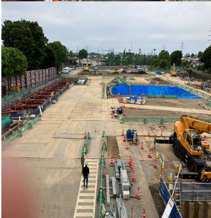
調節池ヤード 南側を望む
