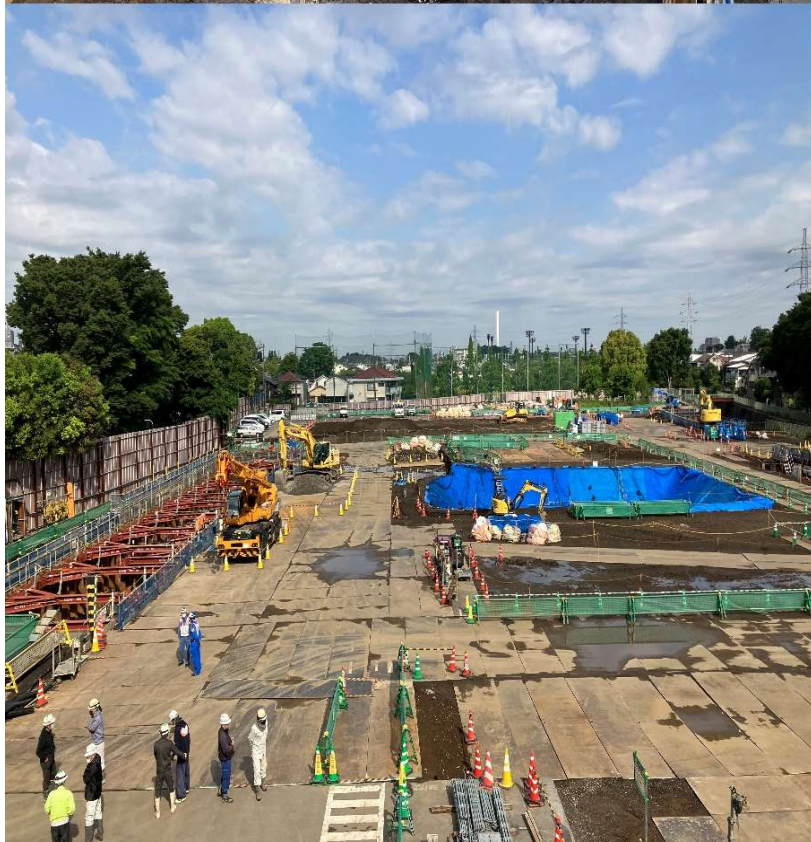
調節池ヤード 南側を望む
