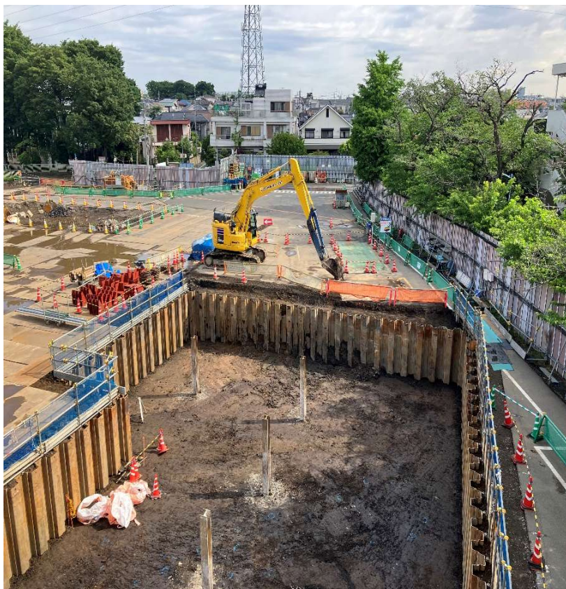
調節池ヤード 北側を望む
