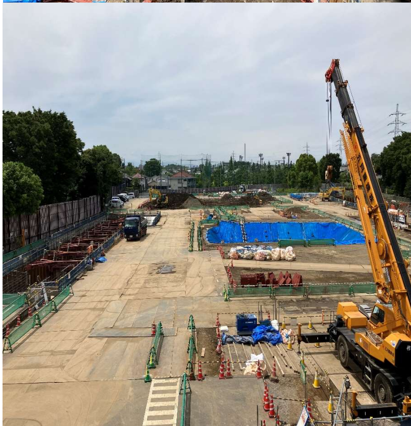
調節池ヤード 南側を望む
