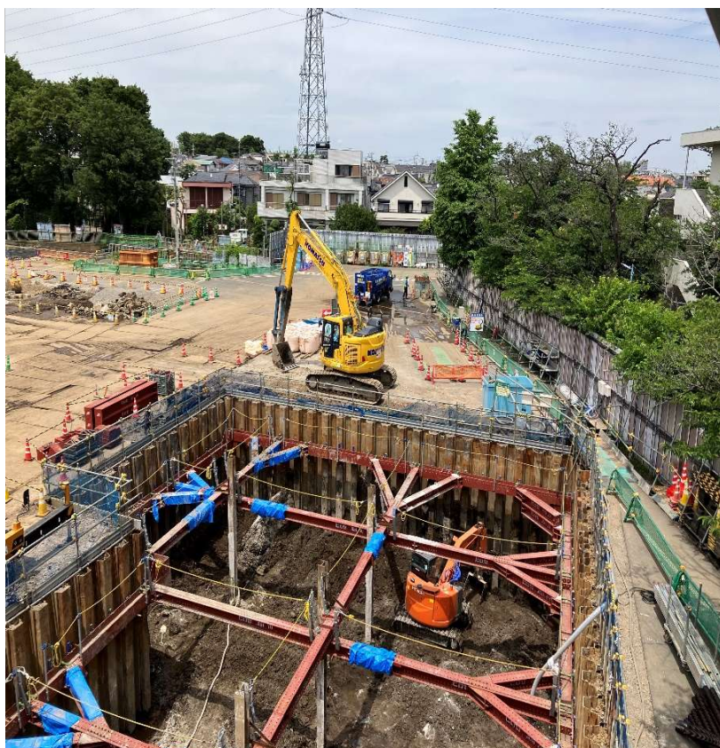
調節池ヤード 北側を望む
