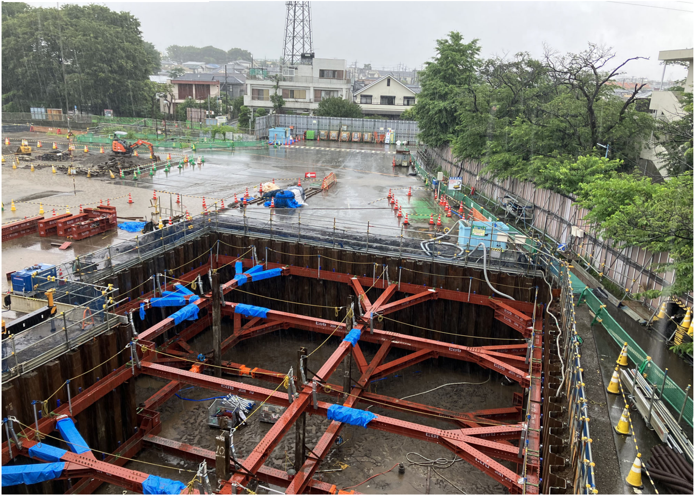
調節池ヤード 北側を望む
