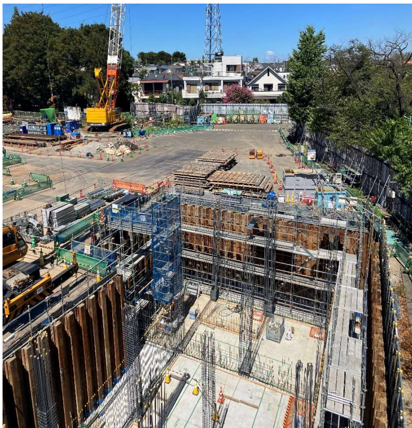
調節池ヤード 北側を望む
