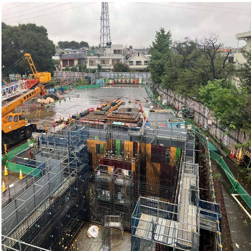
調節池ヤード 北側を望む
