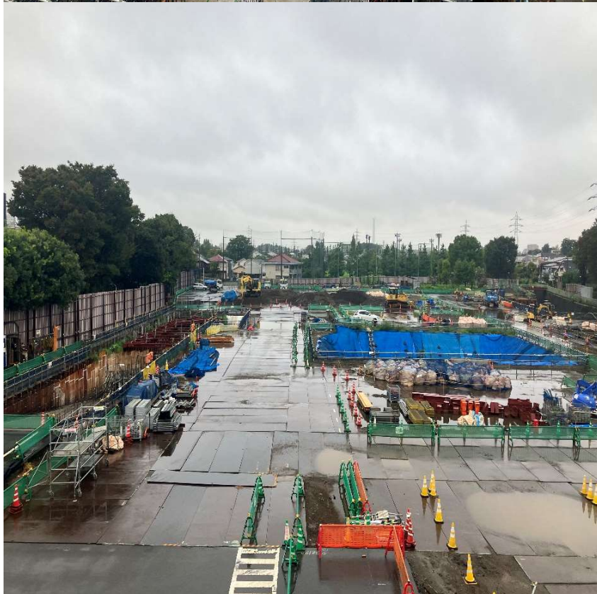
調節池ヤード 南側を望む
