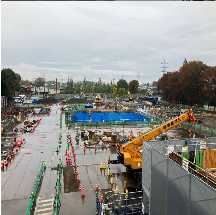
調節池ヤード 南側を望む
