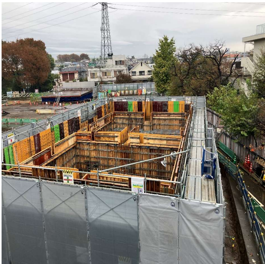
調節池ヤード 北側を望む
