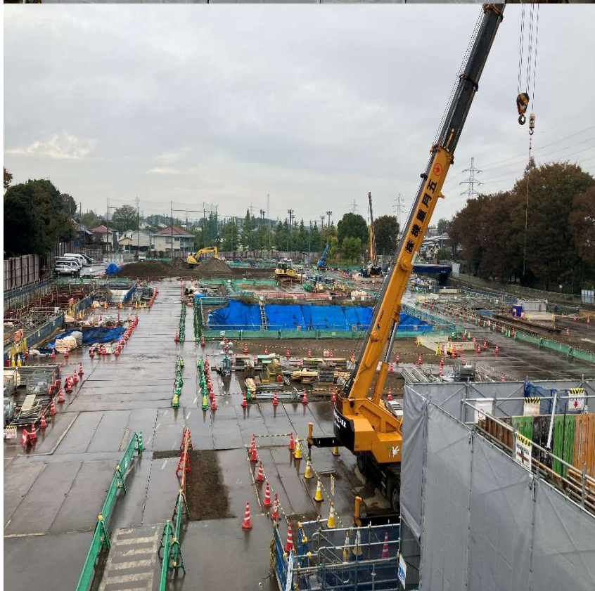
調節池ヤード 南側を望む
