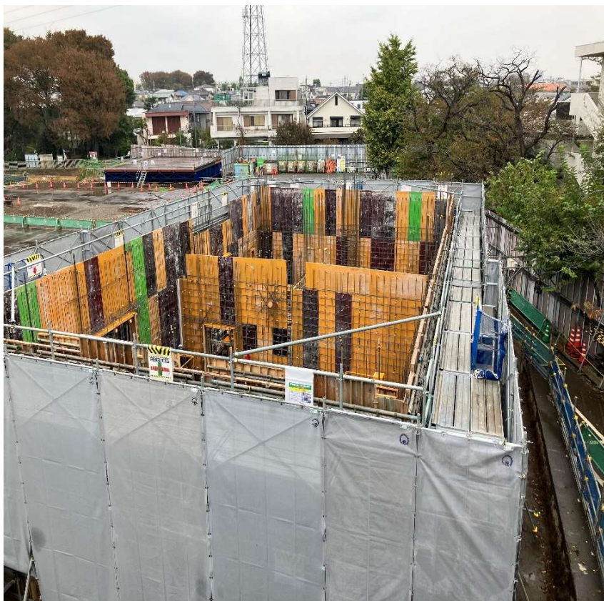
調節池ヤード 北側を望む
