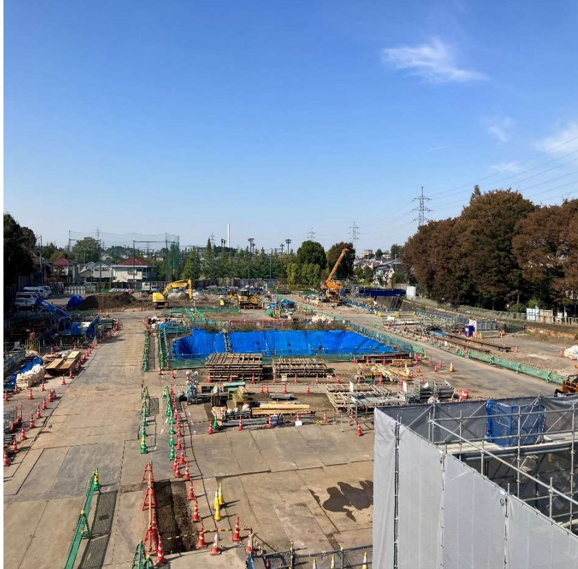
調節池ヤード 南側を望む
