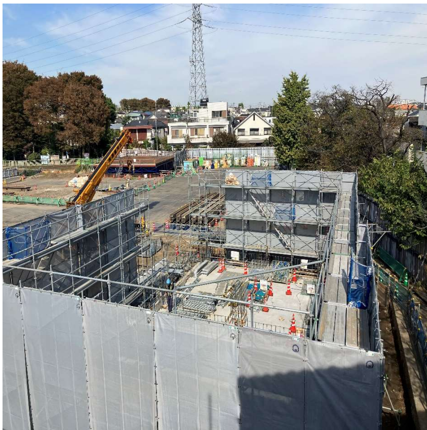
調節池ヤード 北側を望む
