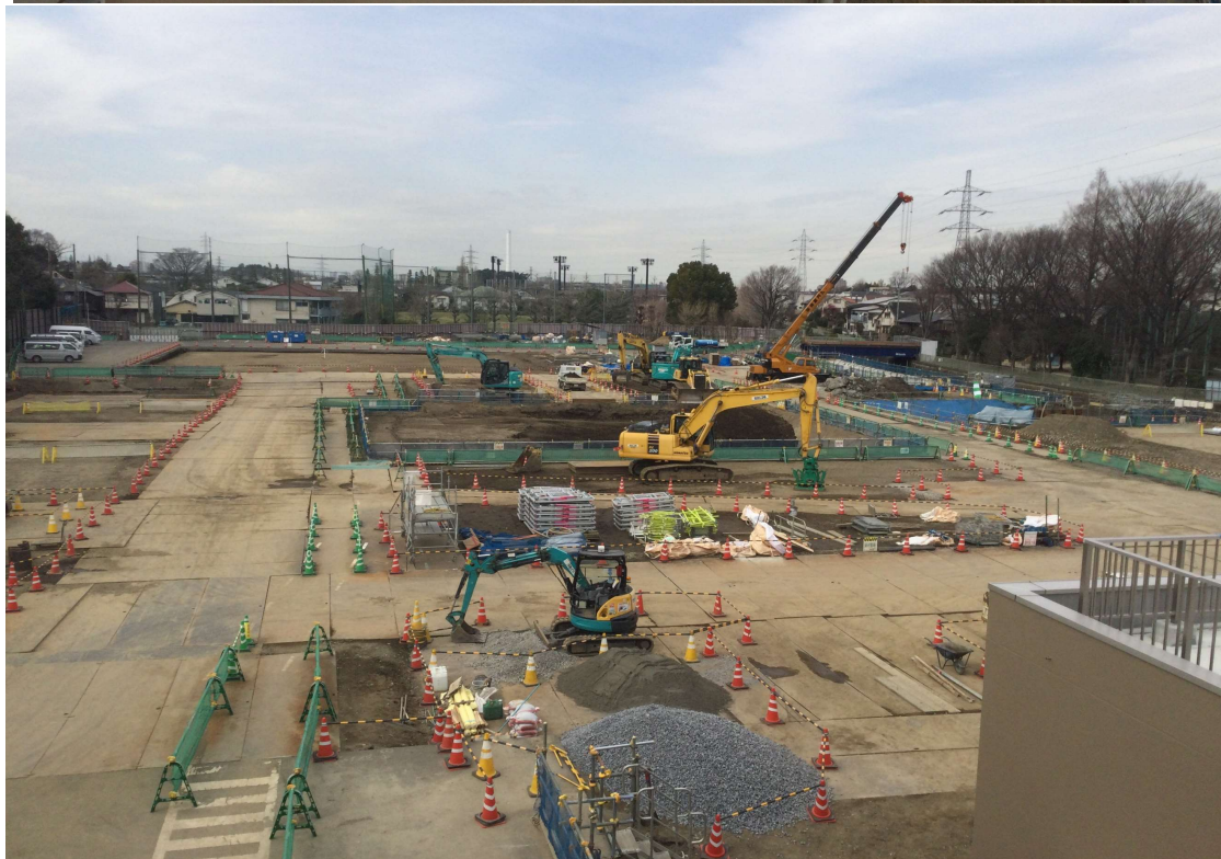
調節池ヤード 南側を望む
