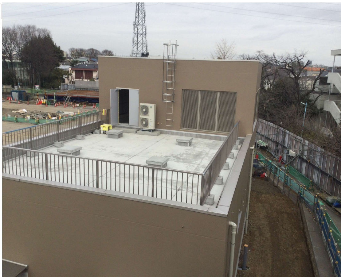
調節池ヤード 北側を望む
