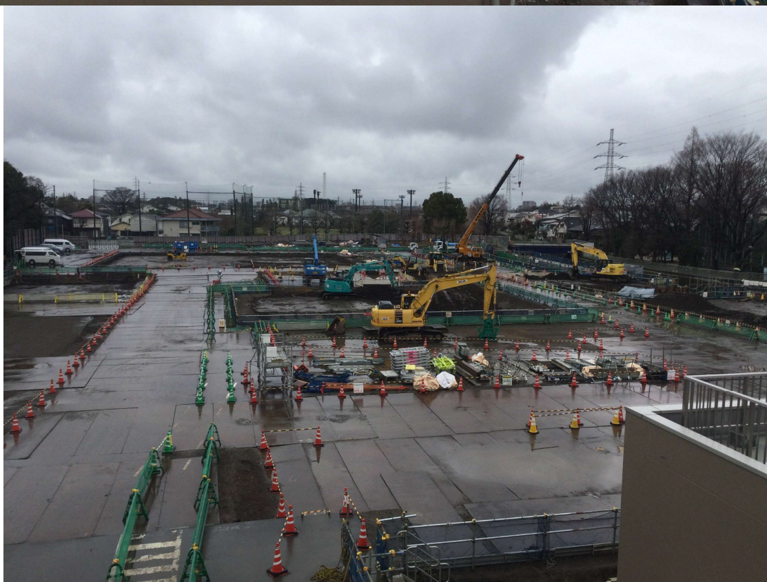
調節池ヤード 南側を望む
