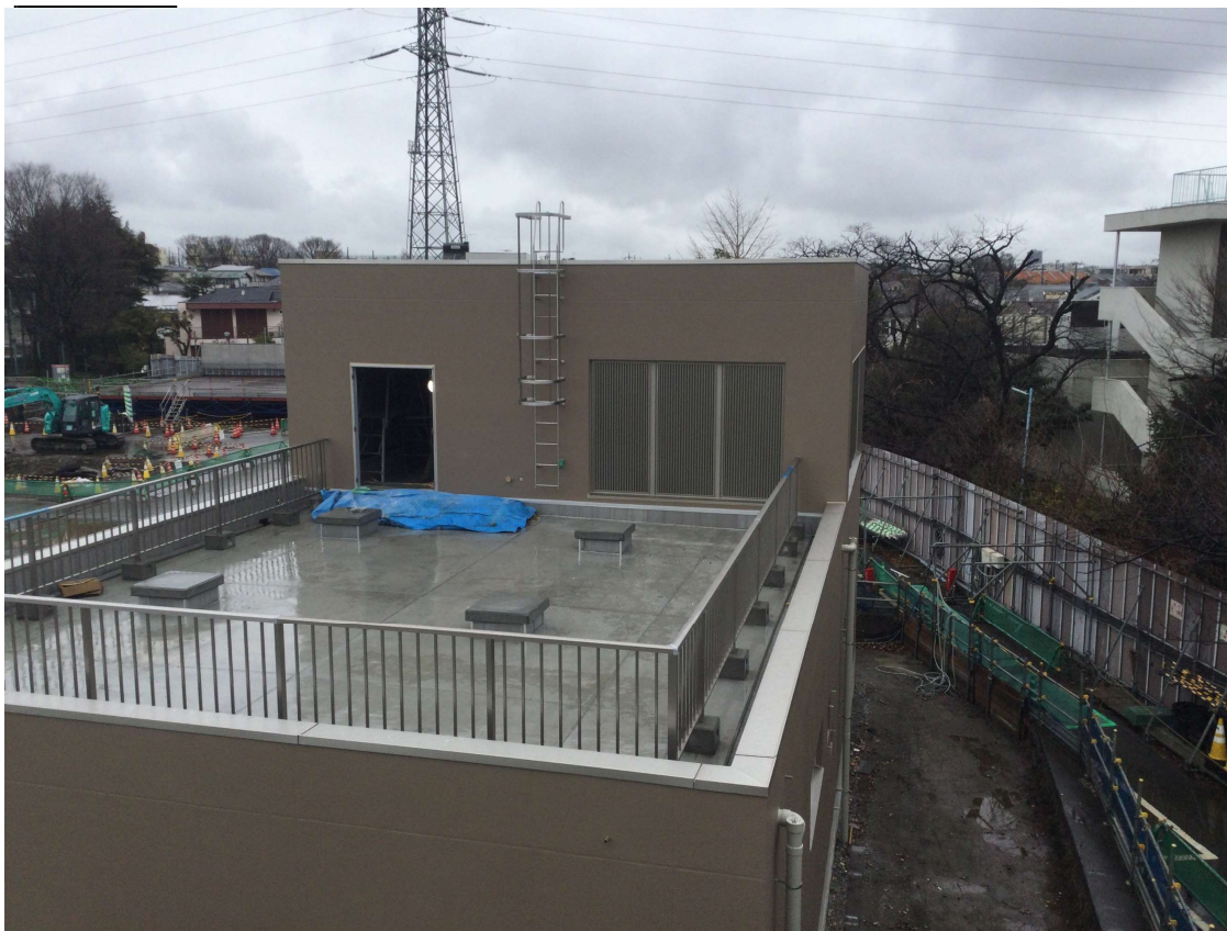
調節池ヤード 北側を望む
