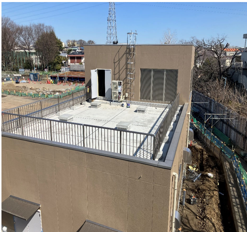
調節池ヤード 北側を望む
