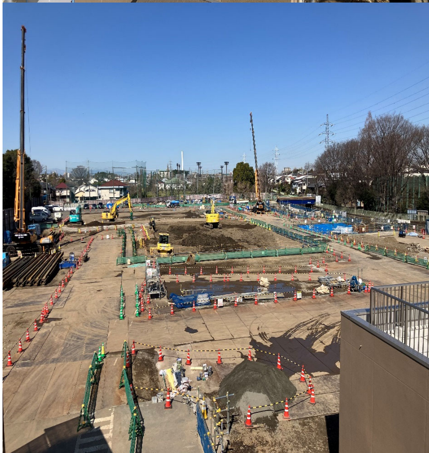
調節池ヤード 南側を望む
