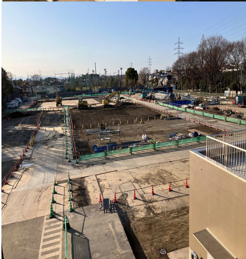
調節池ヤード 南側を望む
