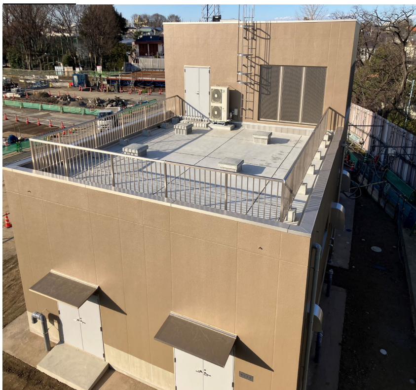
調節池ヤード 北側を望む
