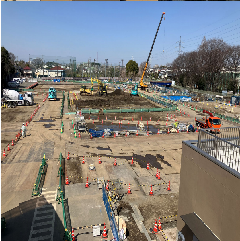
調節池ヤード 南側を望む
