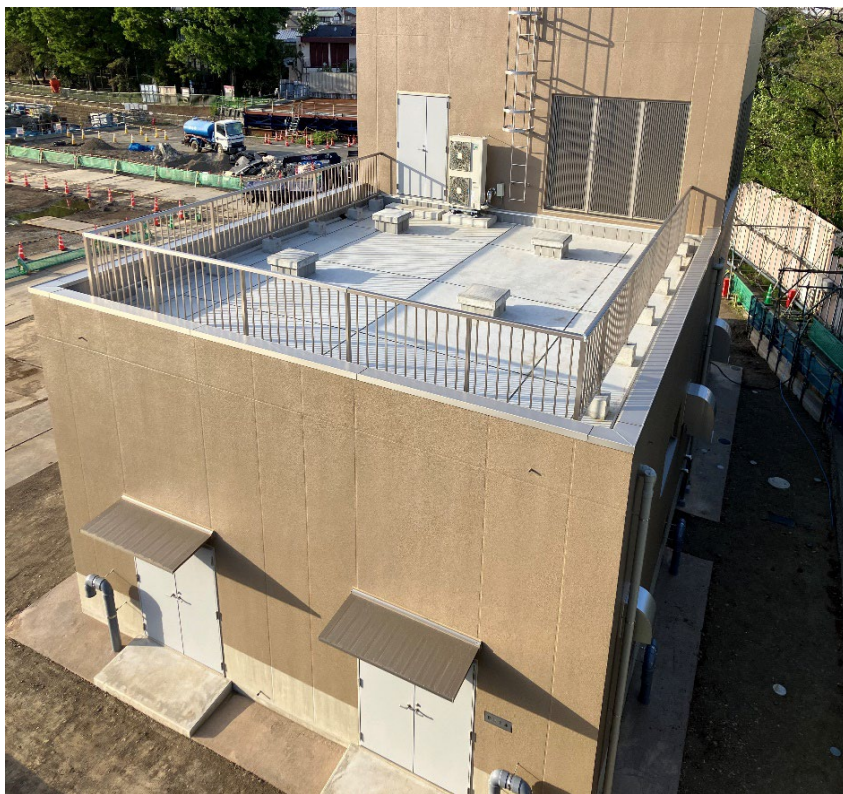
調節池ヤード 北側を望む
