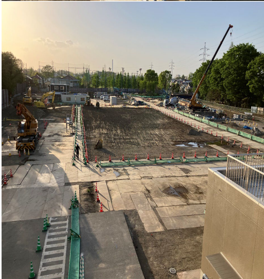
調節池ヤード 南側を望む
