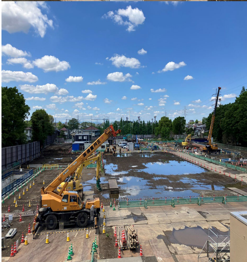
調節池ヤード 南側を望む
