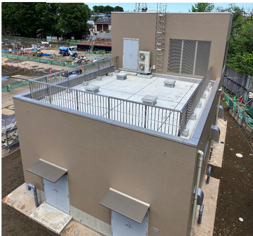
調節池ヤード 北側を望む
