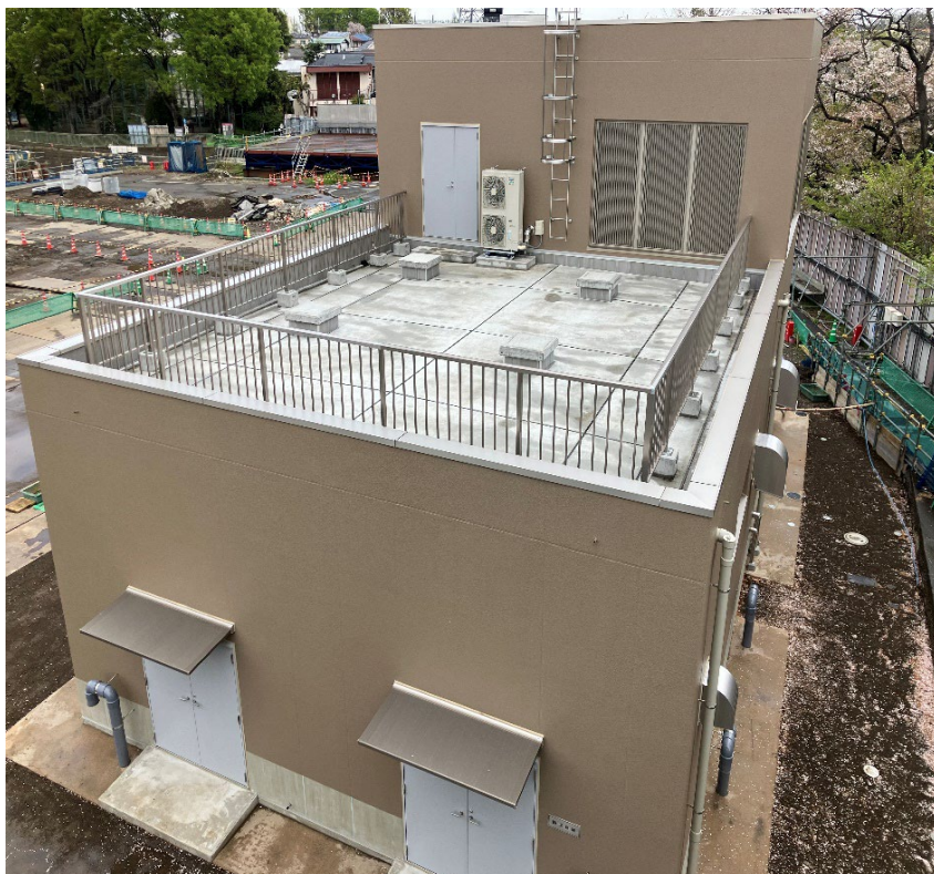
調節池ヤード 北側を望む
