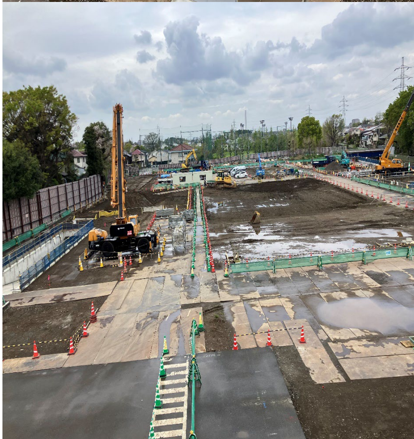
調節池ヤード 南側を望む
