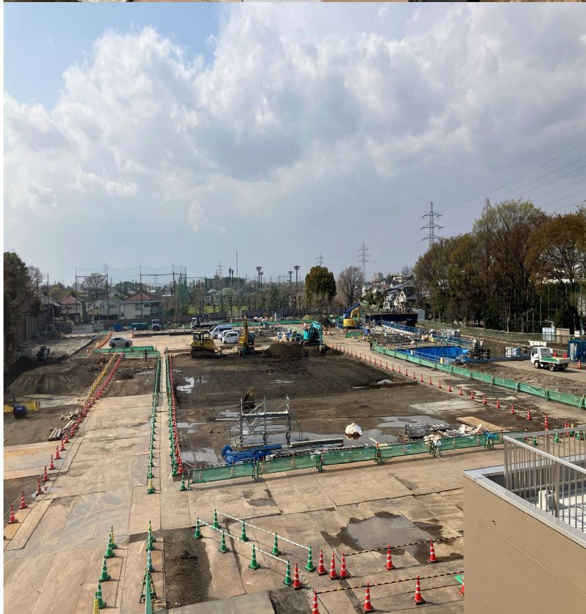
調節池ヤード 南側を望む
