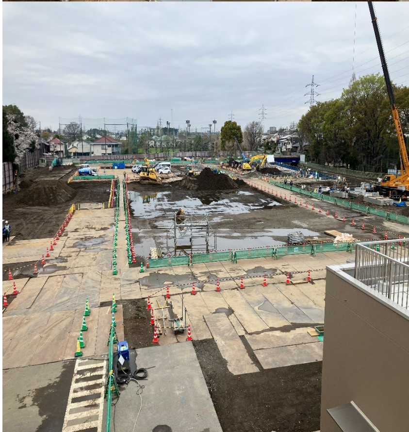
調節池ヤード 南側を望む
